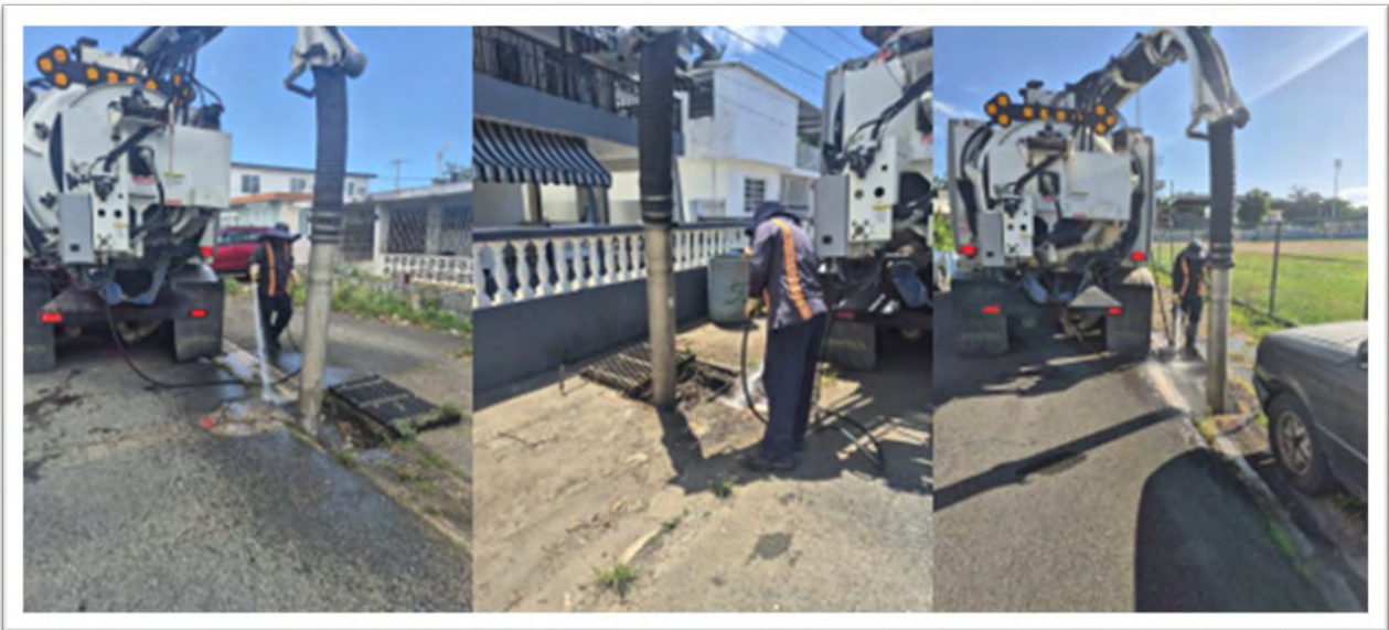
Ilustración 26: Limpieza de alcantarillas Toa Baja Pueblo, Toaville y Sector Monserrate
