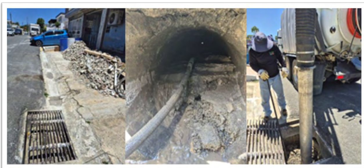
Ilustración 15: Limpieza y destape de sedimento en alcantarillado pluvial
