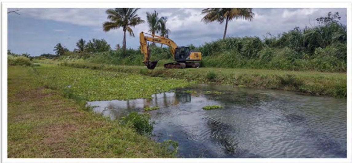
Imagen 5: Limpieza de canal
