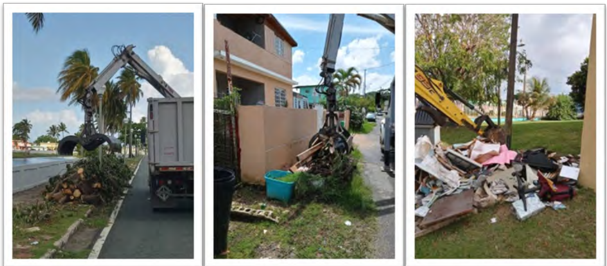
Imagen 16: Recogido de escombros
