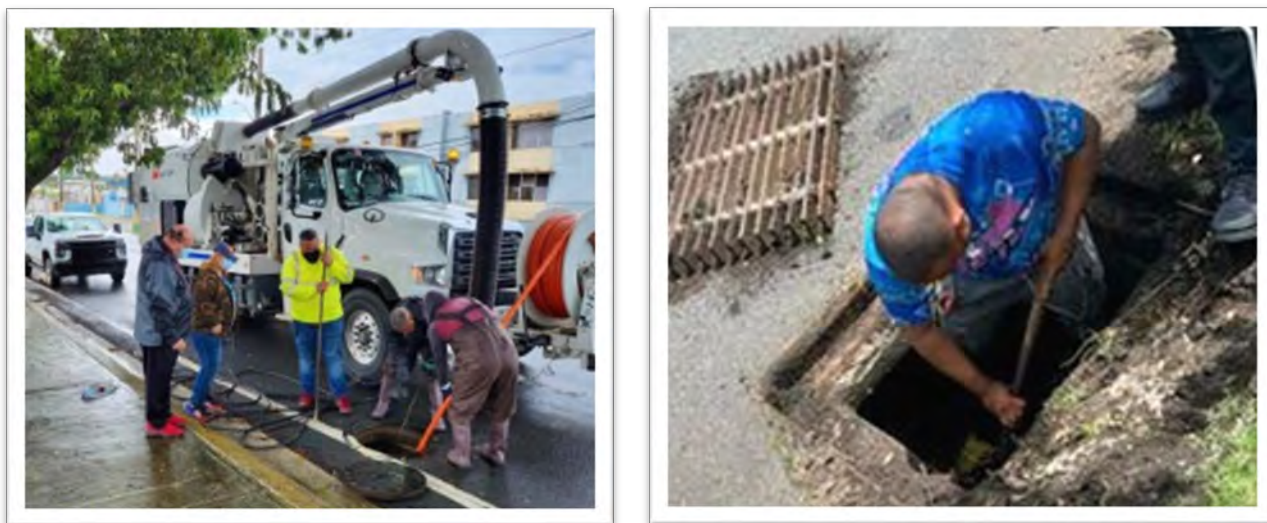
Imagen 15: Limpieza de alcantarillas
