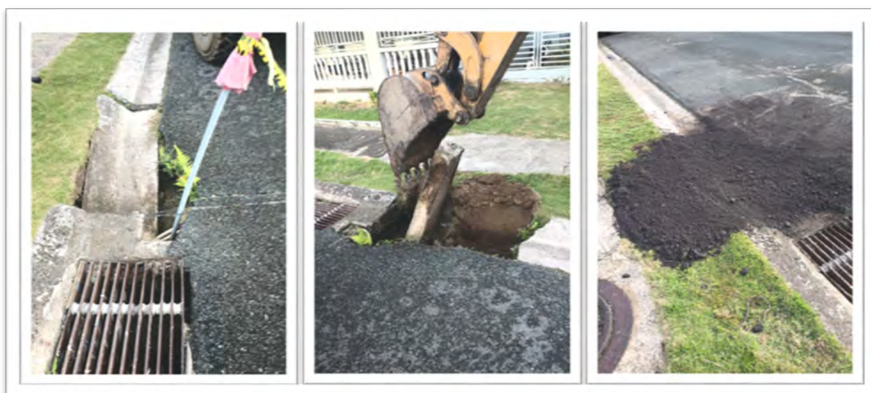
Ilustración 22: Reparación de Infraestructura Pluvial Colapsada
