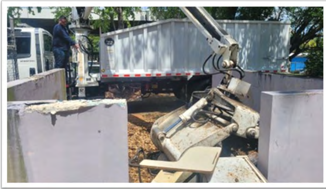
Ilustración 35: Remoción de escombros Escuela Martín García Giusti, Barrio Pájaros
