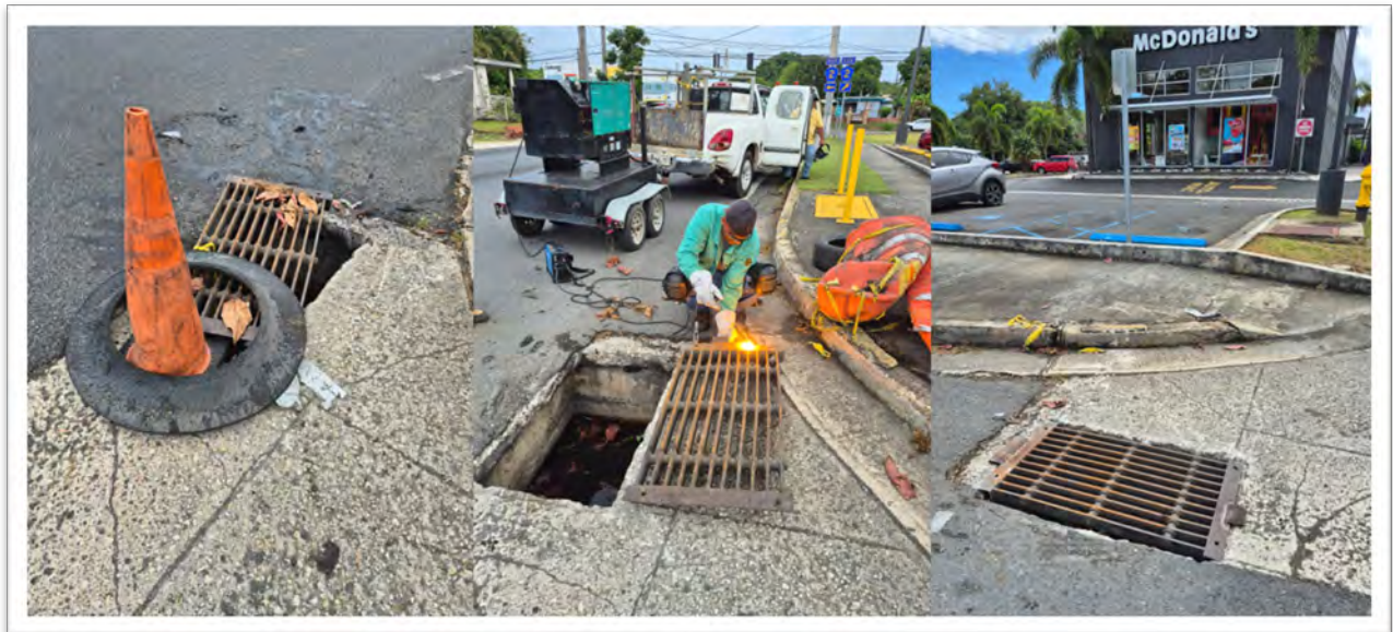
Ilustración 34: Reparación de alcantarilla carretera 863, Barrio Pájaros
